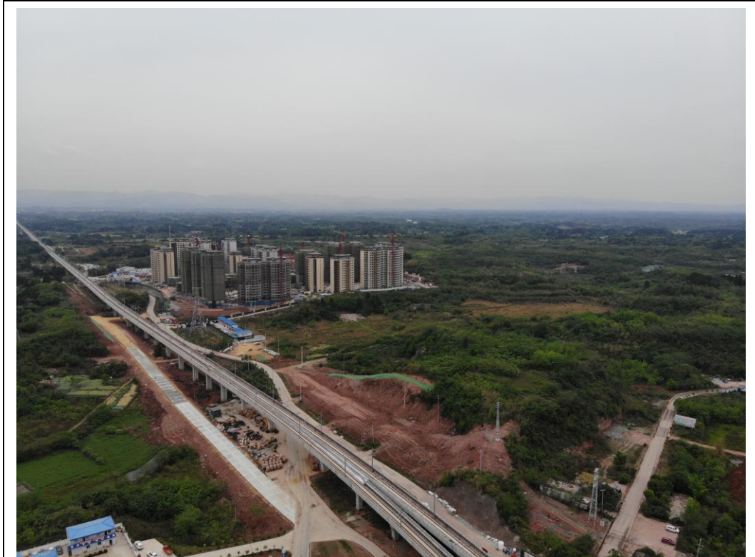
项目区周围交通（在建南四线）
